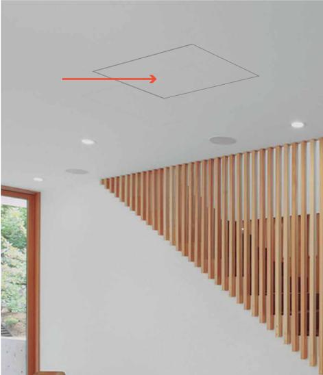
Las Tapas de Inspección ACON TIO se fabrican a partir del plegado de la placa de yeso, logrando una excelente coplanaridad entre Marco y Tapa. Las mismas están desarrolladas para ser instaladas en cielorraso de placa de yeso, obteniendo una superficie totalmente disimulada en el mismo. Son utilizadas habitualmente para el acceso a las instalaciones eléctricas, informáticas entre otras.
